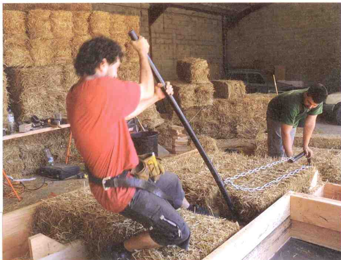
La réalisation des murs en paille en atelier facilite la pose et ne souffre pas des aléas climatiques.
